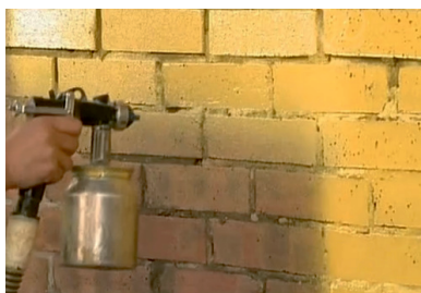
строительство заборов под покраску
