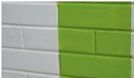
облицовка фасадов плиткой для дальнейшей покраски
