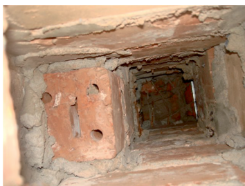
кладка вентиляционных каналов
