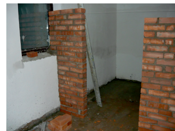
возведение внутренних перегородок
