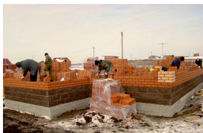
возведение несущих стен
