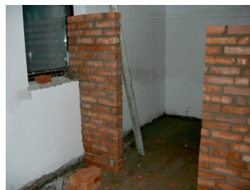
возведение внутренних перегородок в 2 кирпича под отделку
