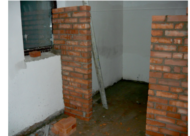
возведение внутренних перегородок
