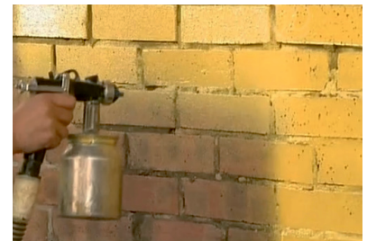
облицовка цоколей узким кирпичом для дальнейшей покраски
