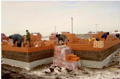
возведение несущих стен
