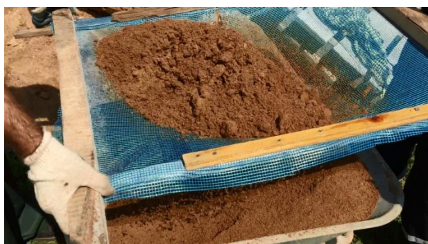
Рис 4. Просеивание песка (слева), подготовка кладочного раствора в бетономешалке (справа)
