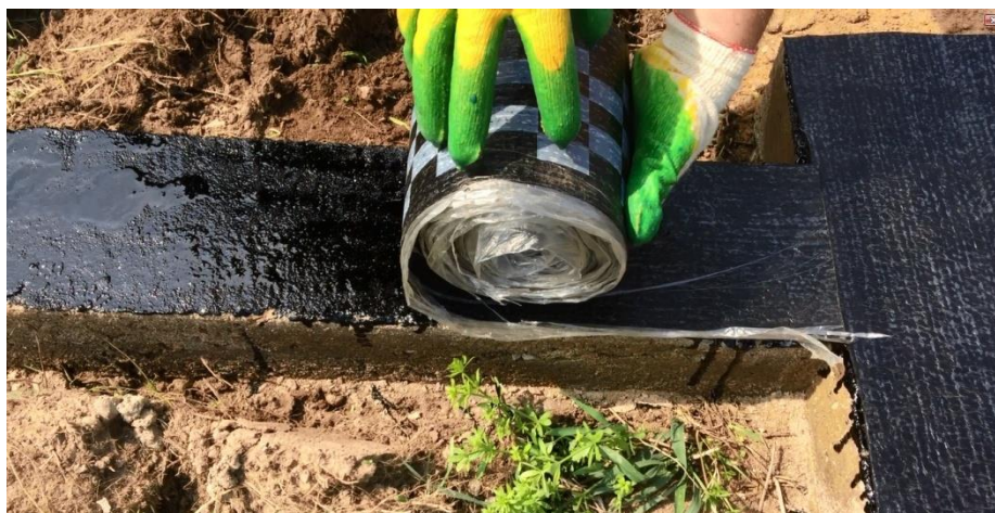
Рис 3. Оклейка фундамента заранее нарезанной гидроизоляционной пленкой
