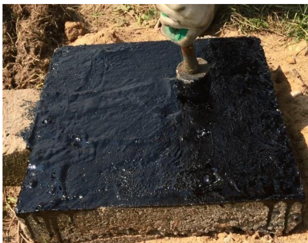
Рис 2. Нанесение слоя мастики (праймера) на фундамент
